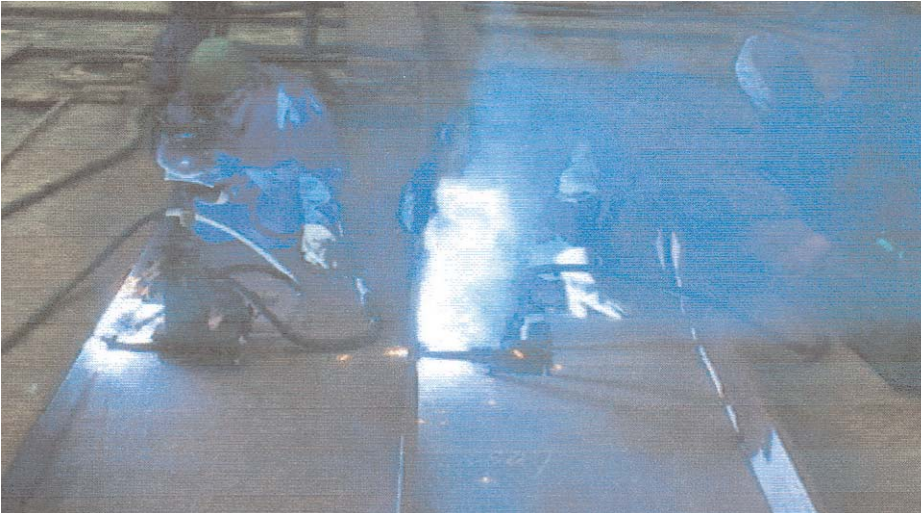
Schweißtraktor mit und ohne Absauganlage
